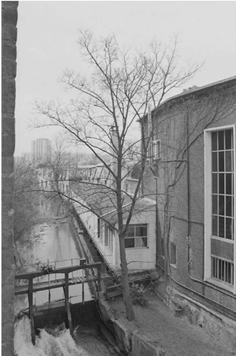
Atelier de fabrication, flanc est.
