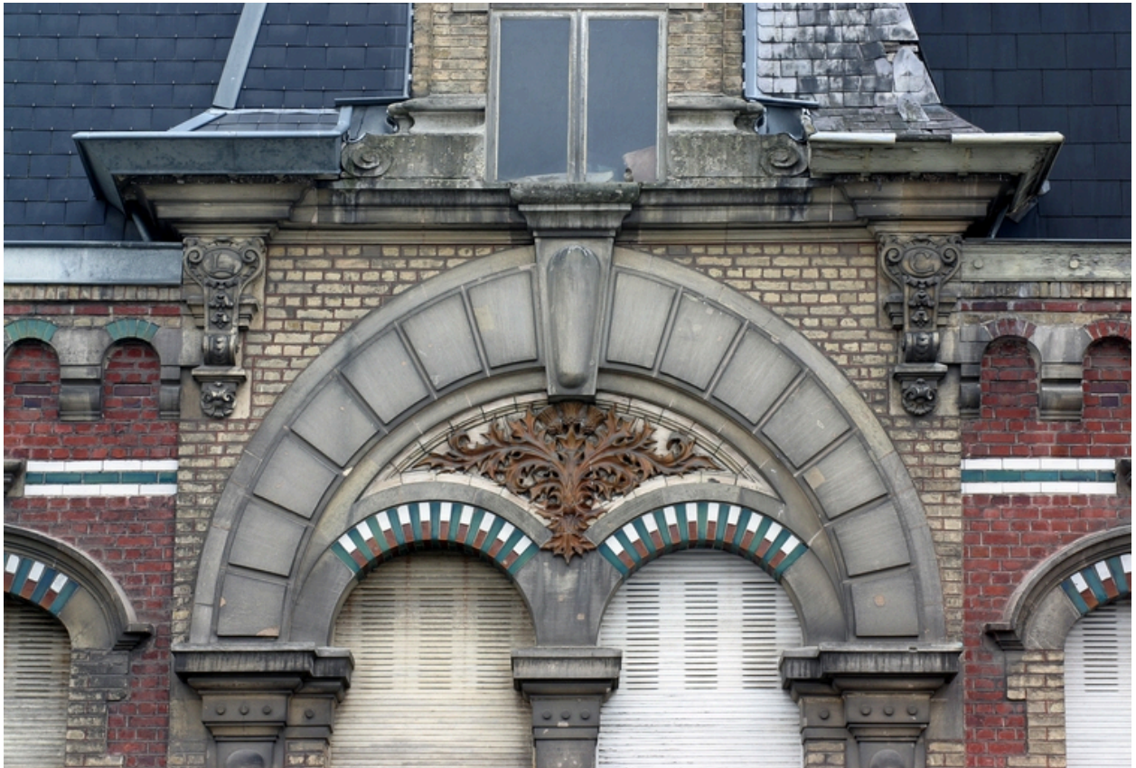
Façade, 6 place du Général Foy : détail.
