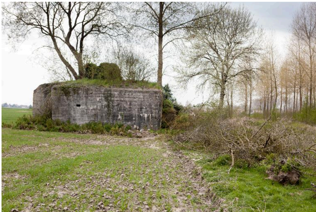
Edifice b : Elévation nord-est
