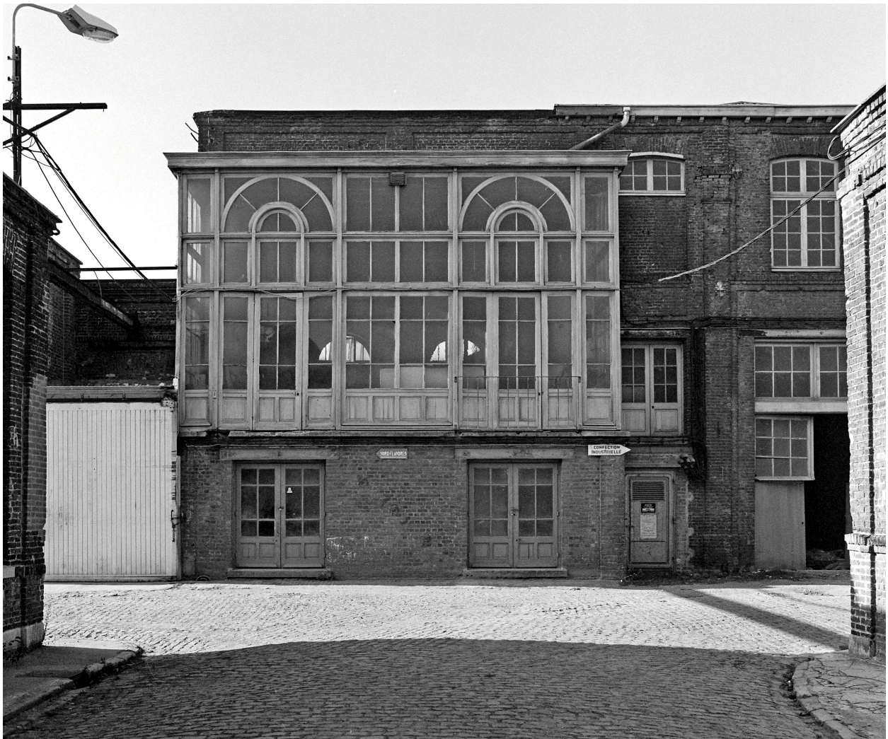
Salle des machines. Élévation antérieure.
