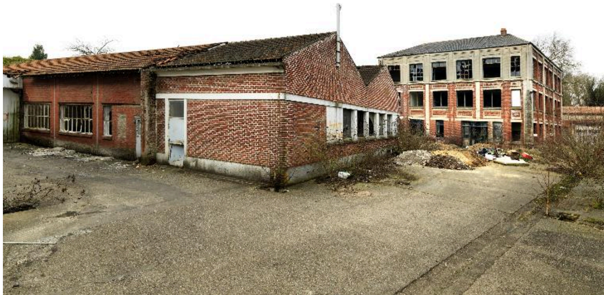
Vue d'ensemble du sud du site industriel.
