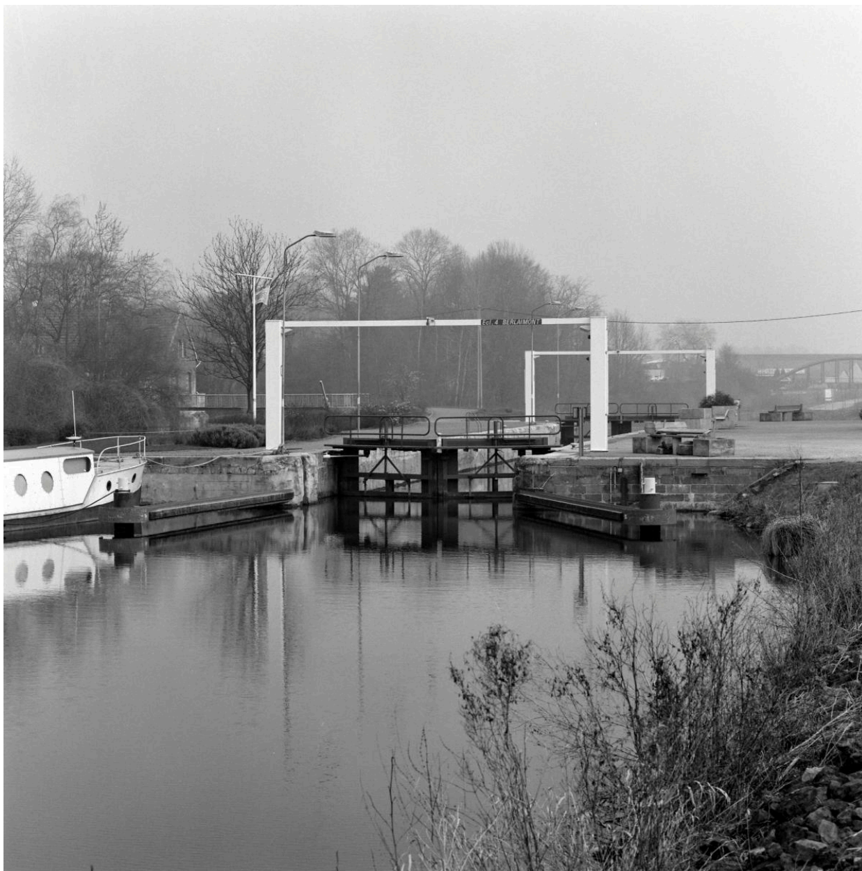
Vue générale de l'écluse n°4 à Berlaimont.
