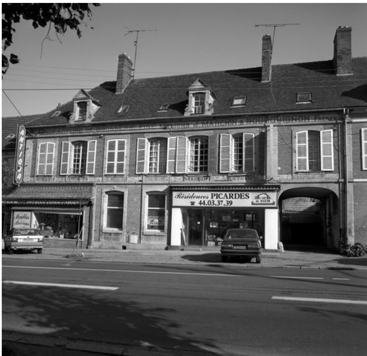
Atelier de fabrication, façade sur rue.
