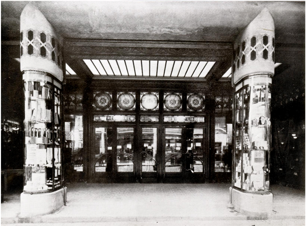
Entrée rue de la Sellerie, vers 1927 (Cité de l'Architecture et du Patrimoine ; fonds des Bétons armés Hennebique 3-D-364-g).
