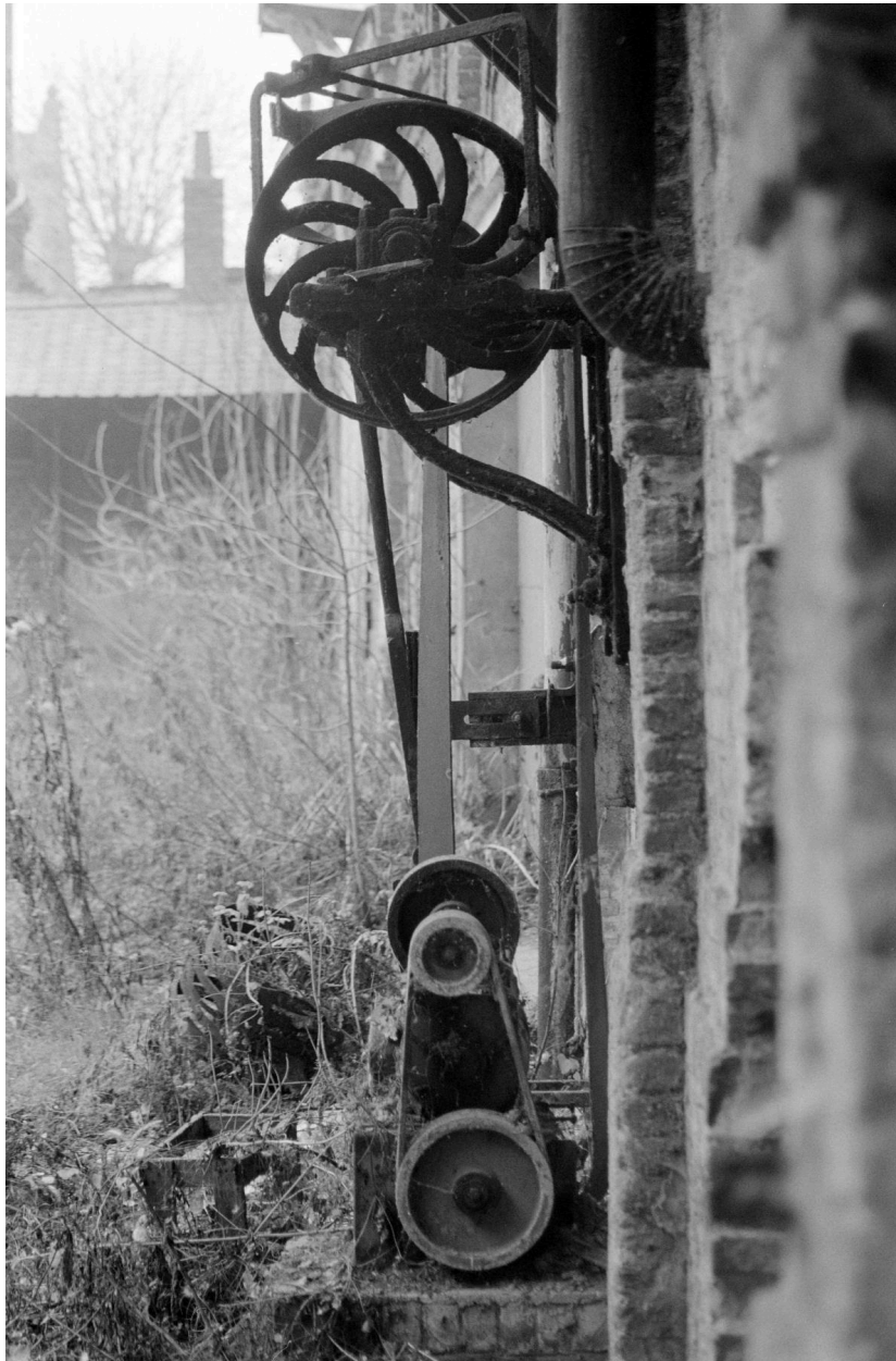
Pompe extérieure de la brasserie.
