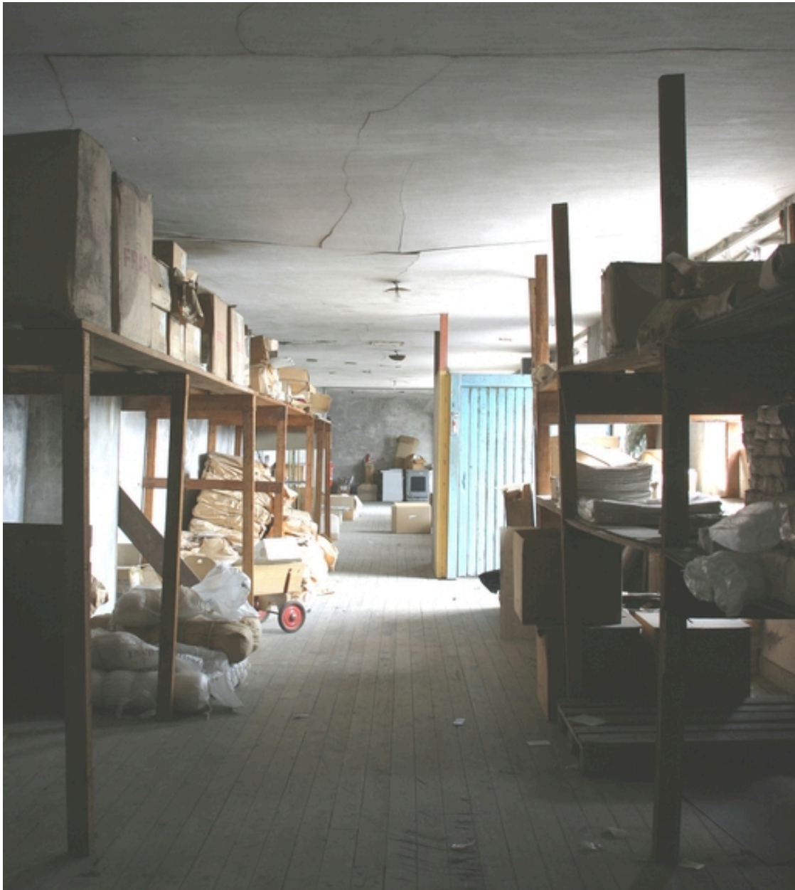
Vue intérieure des anciens magasins (aile gauche, 1er étage).
