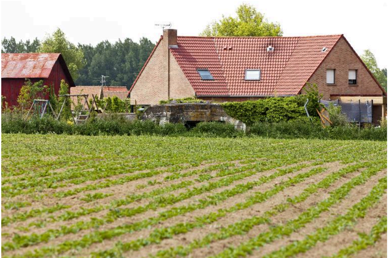
Vue générale vers le sud-ouest, depuis le chemin vicinal
