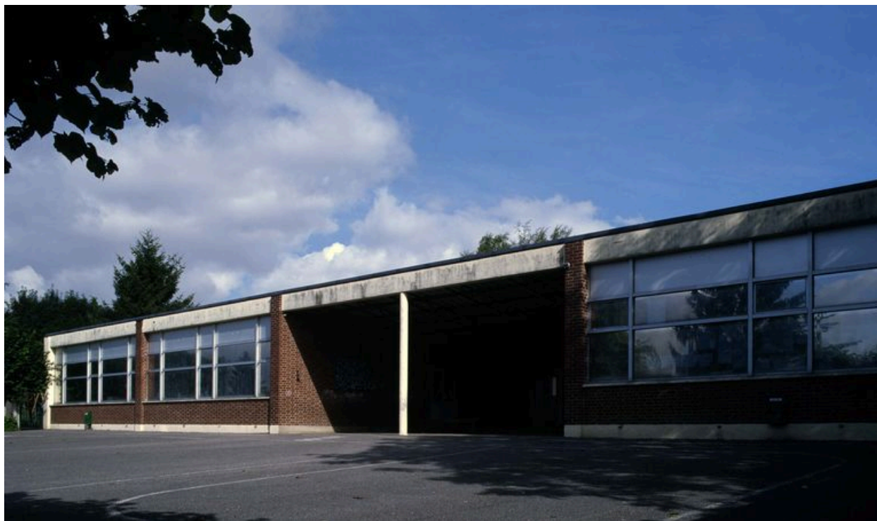
Pernois, groupe scolaire, Joseph Andrieu architecte, 1957.
