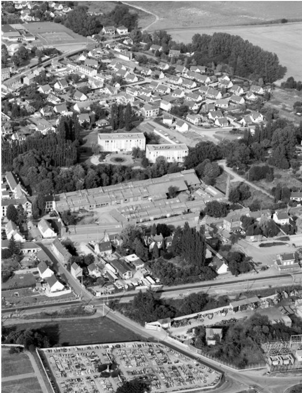
Vue aérienne de l'usine en 1994.
