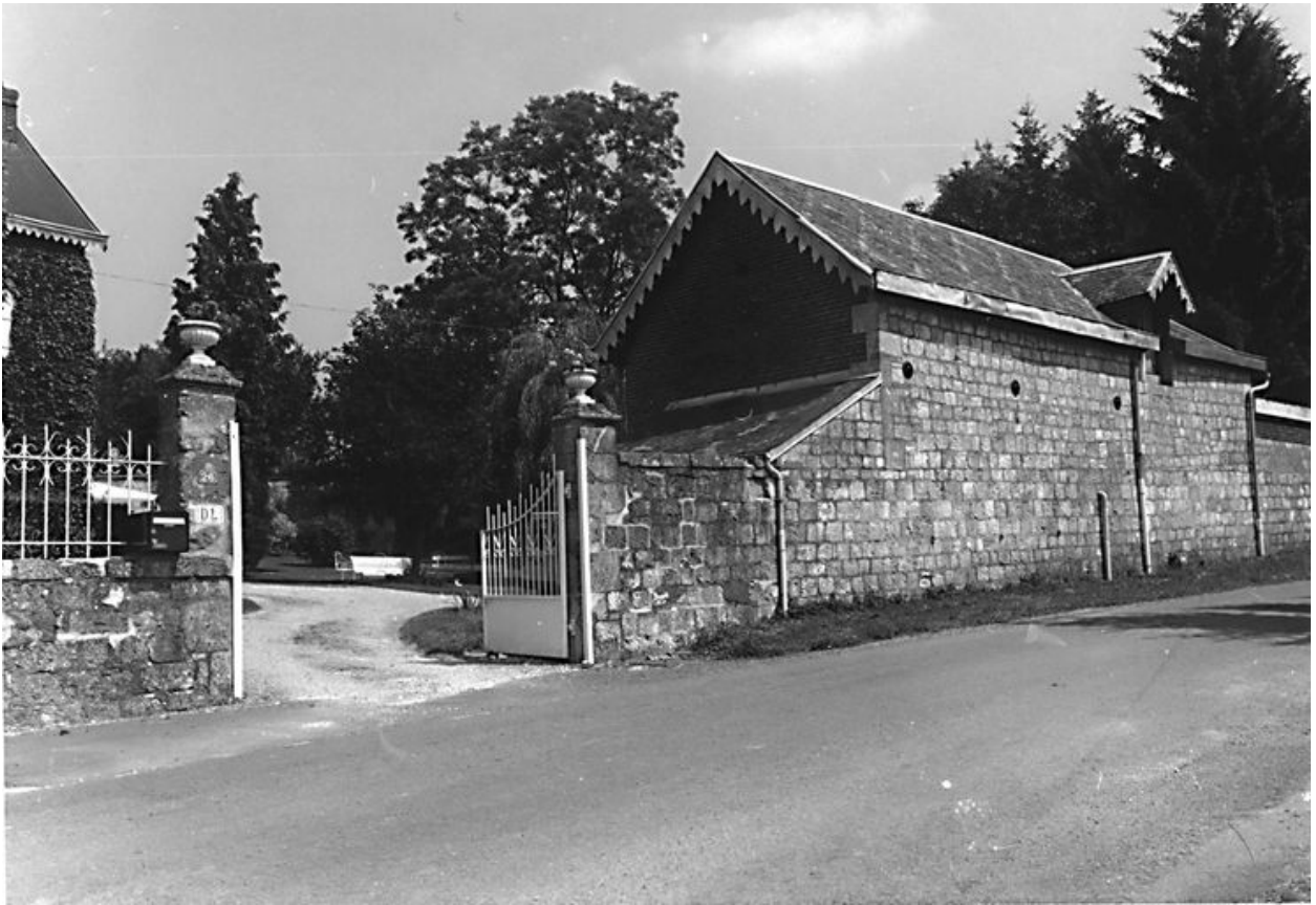
Elévation sur rue des écuries.
