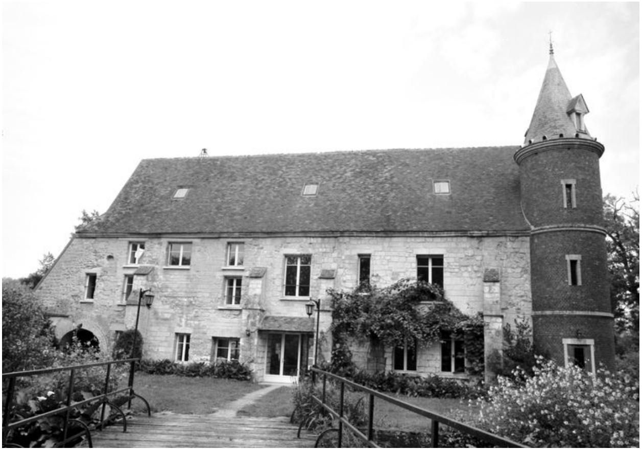
Vue générale du moulin, côté nord, en 1996.
