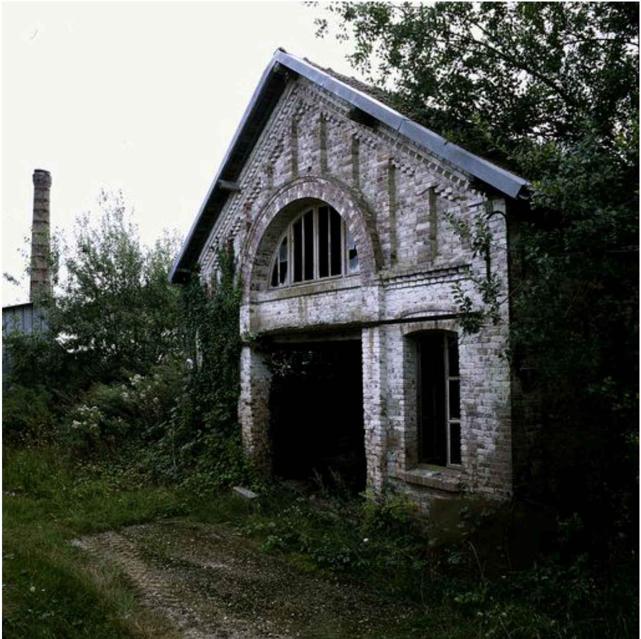
Façade de l'atelier de broyage.
