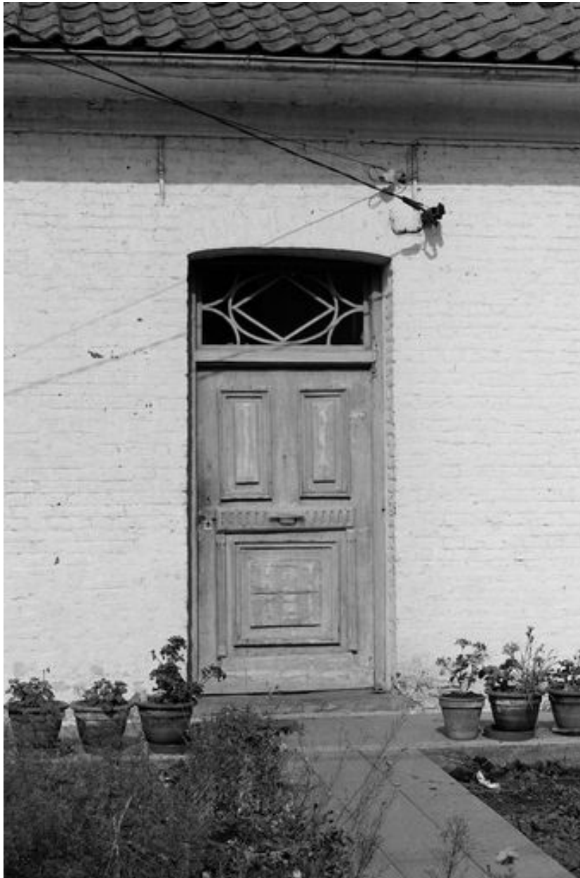
Détail de la porte et de l'imposte.
