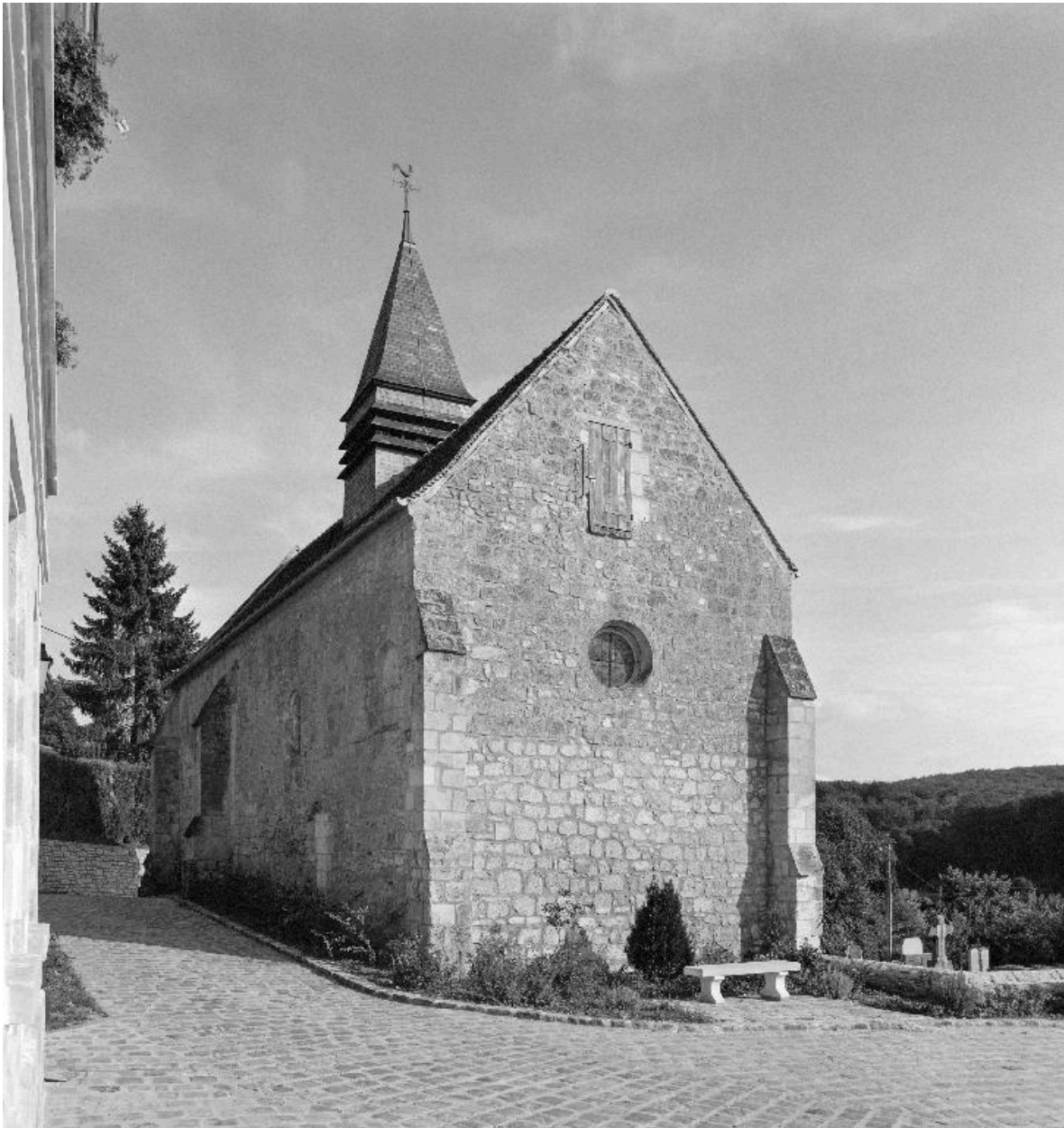
Vue de l'église, depuis le nord-ouest.
