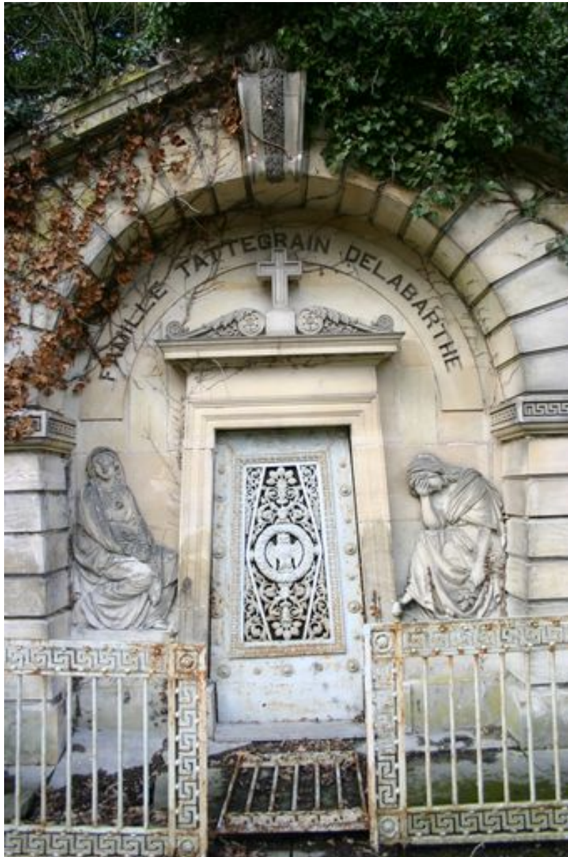
Vue rapprochée de la façade sculptée du tombeau-chapelle.
