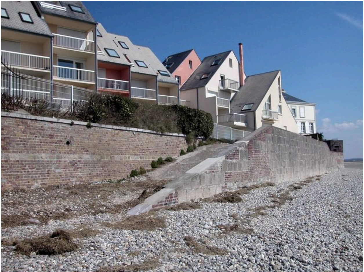
La rampe d'accès à la plage, seul vestige conservé de la terrasse du Grand Hôtel du Crotoy.
