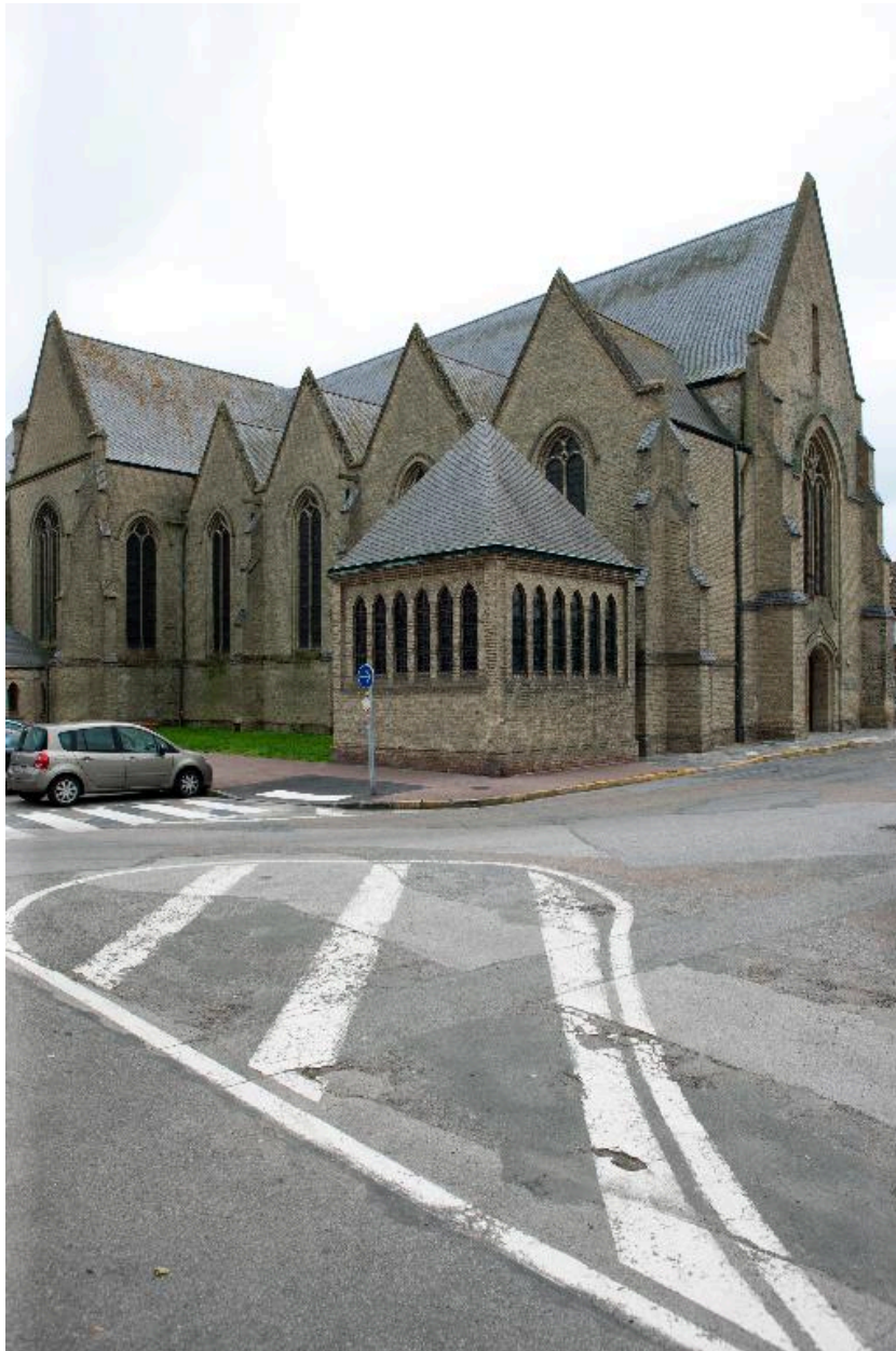
Vue générale du bas-côté nord de l'église.
