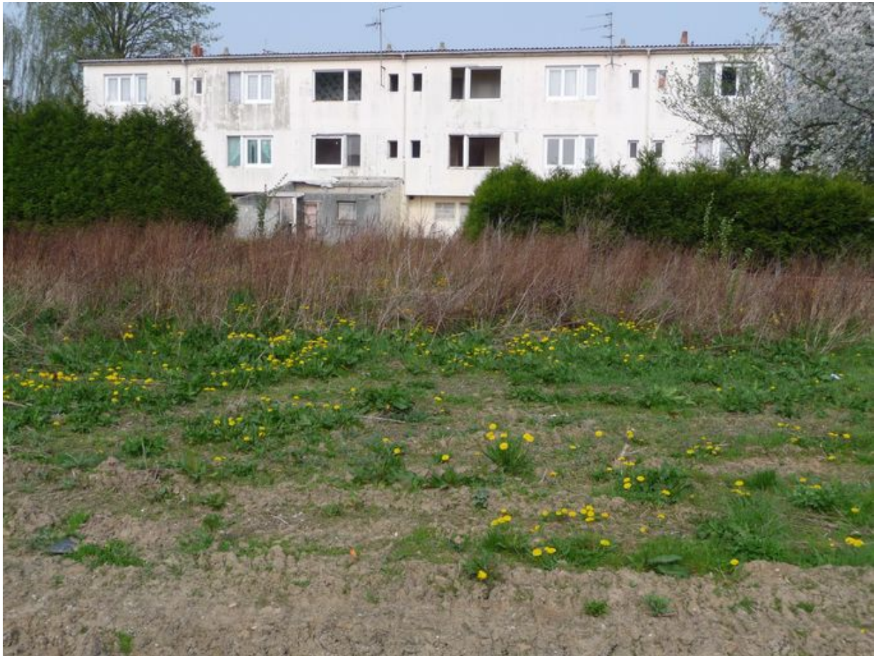
Vue générale d'un groupe de six logements.
