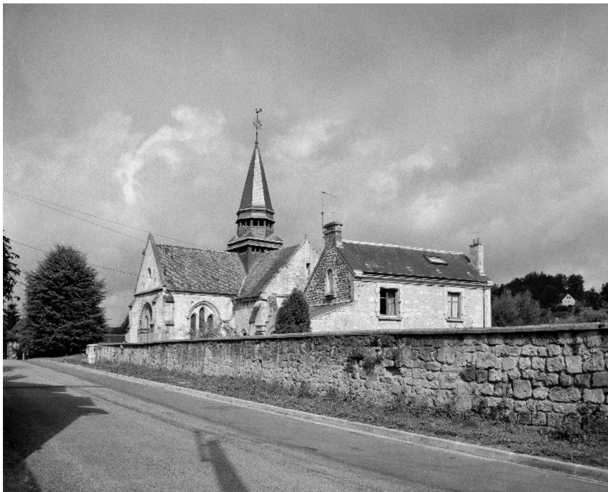
Vue générale de l'église et de l'ancien presbytère, depuis le sud-est.
