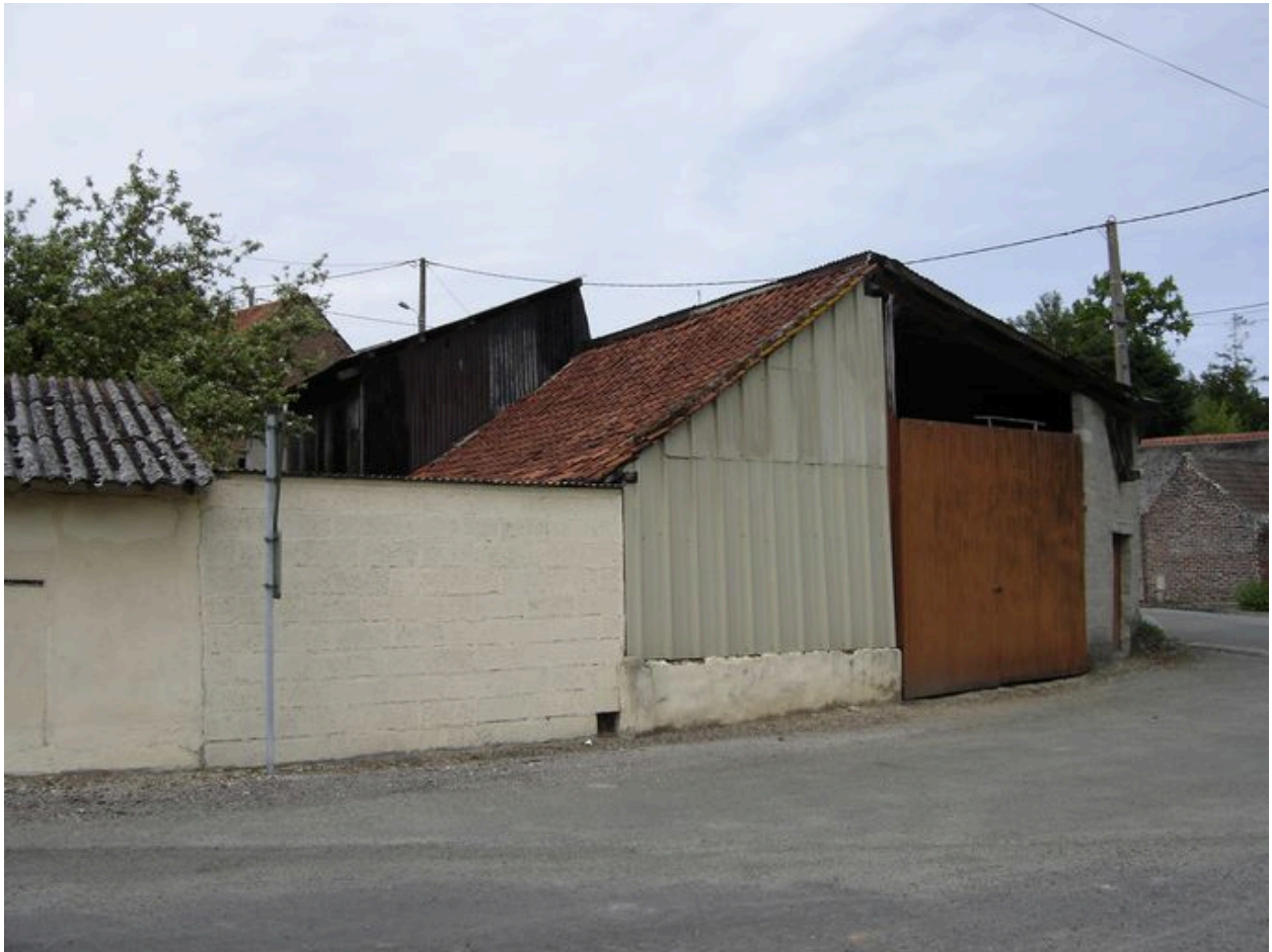
Vue de l'ancienne grange donnant sur la rue Huré.
