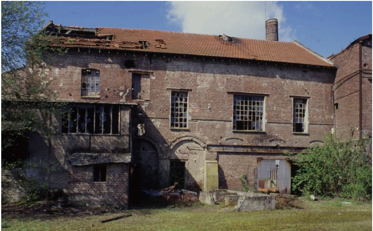
La façade arrière de l'atelier de fabrication en 1994.
