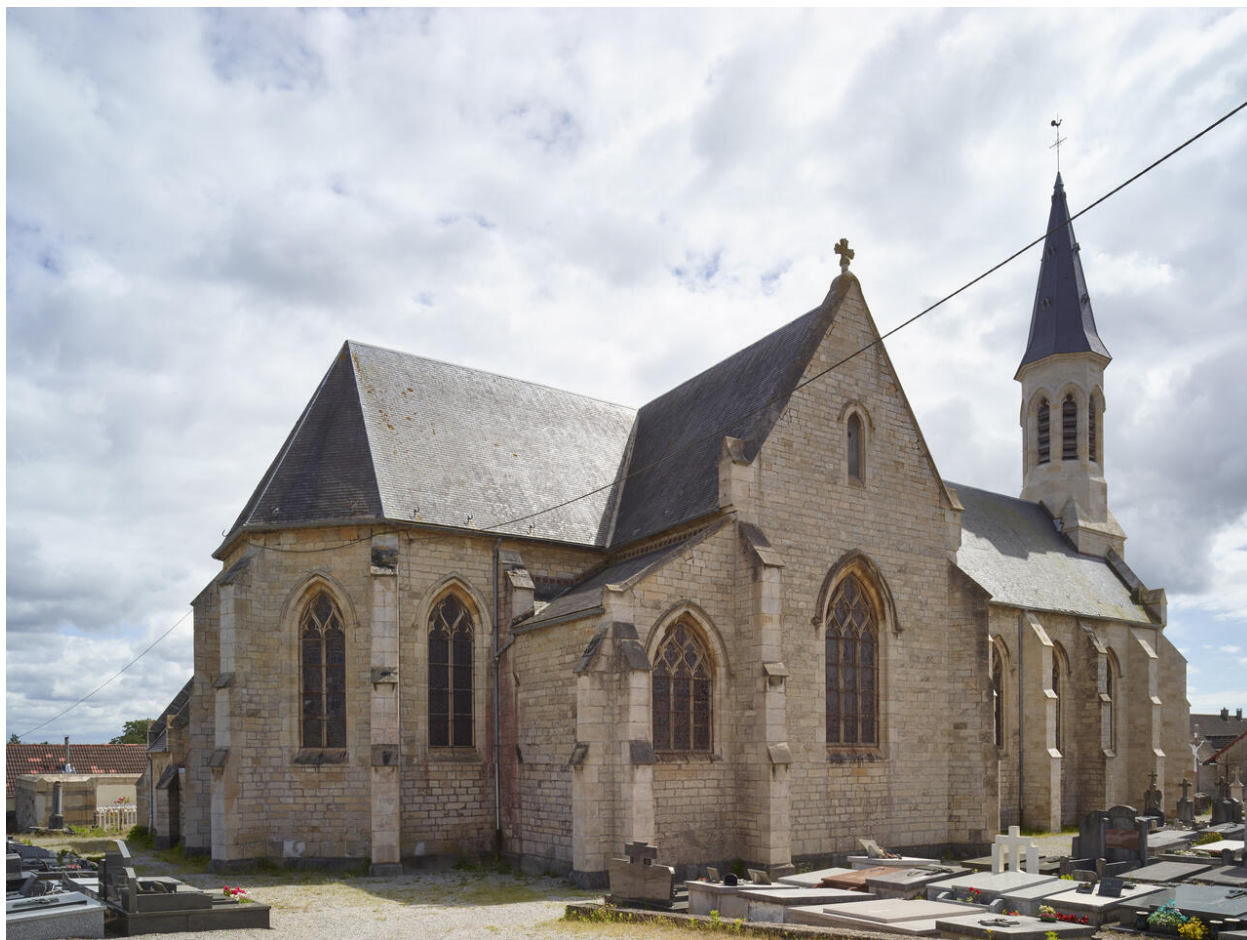
Vue de l'élévation nord.
