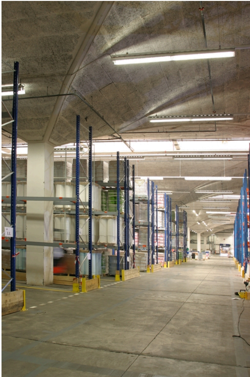
Entrepôt industriel de 1966.
