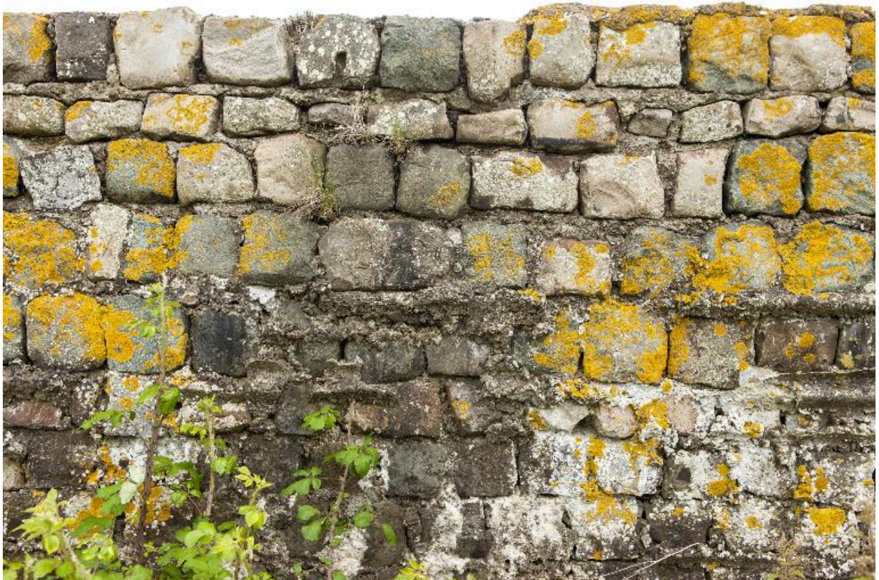
Détail de l'essentage de pavé de l'élévation nord-ouest
