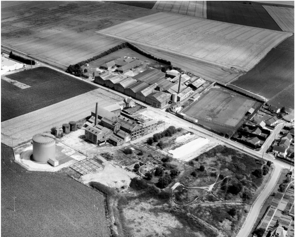
Vue aérienne, flanc nord-ouest.
