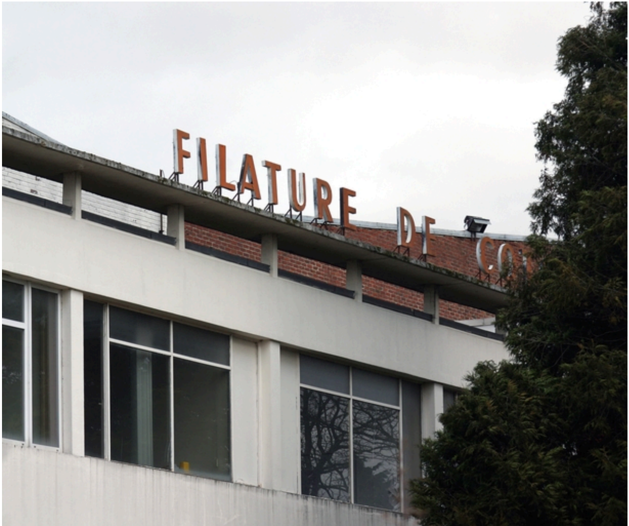
La façade des bureaux : détail.
