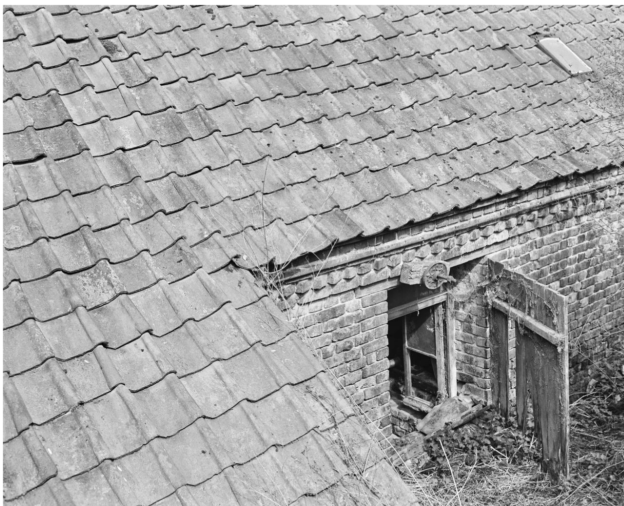
Ouverture sur le bâtiment d'eau.
