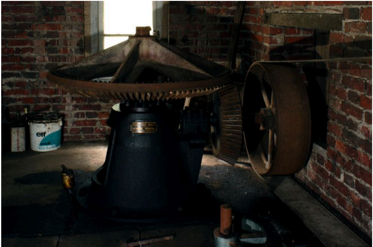
Vue de la partie supérieure de la turbine verticale.
