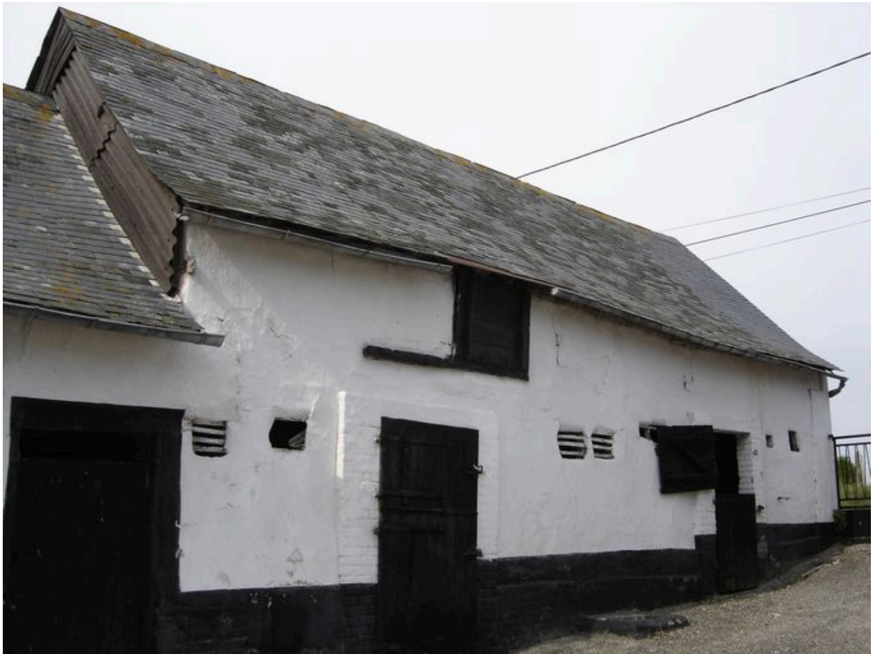
Vue des étables sur rue.
