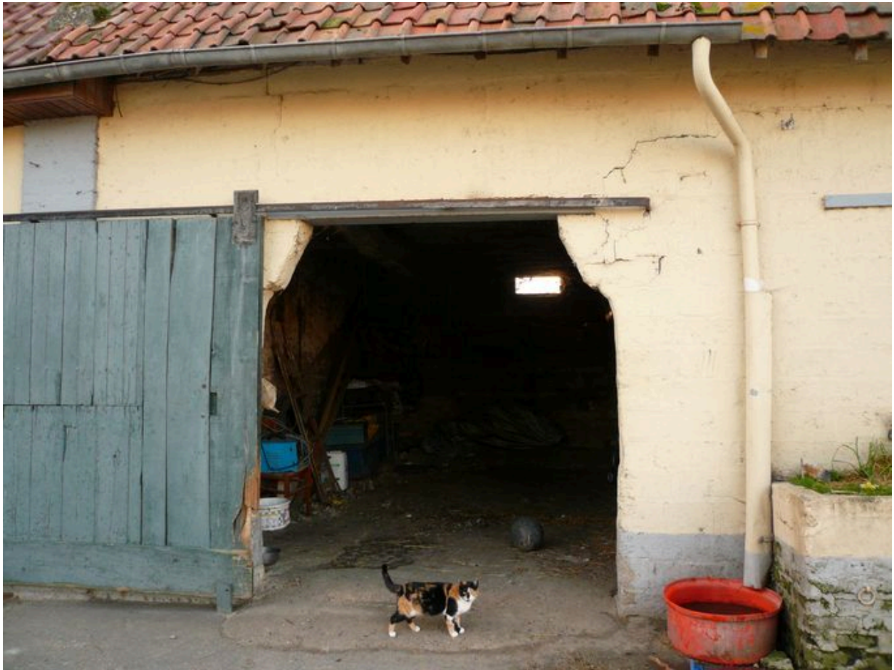
Vue de l'entrée de l'écurie située dans le prologement du logis.
