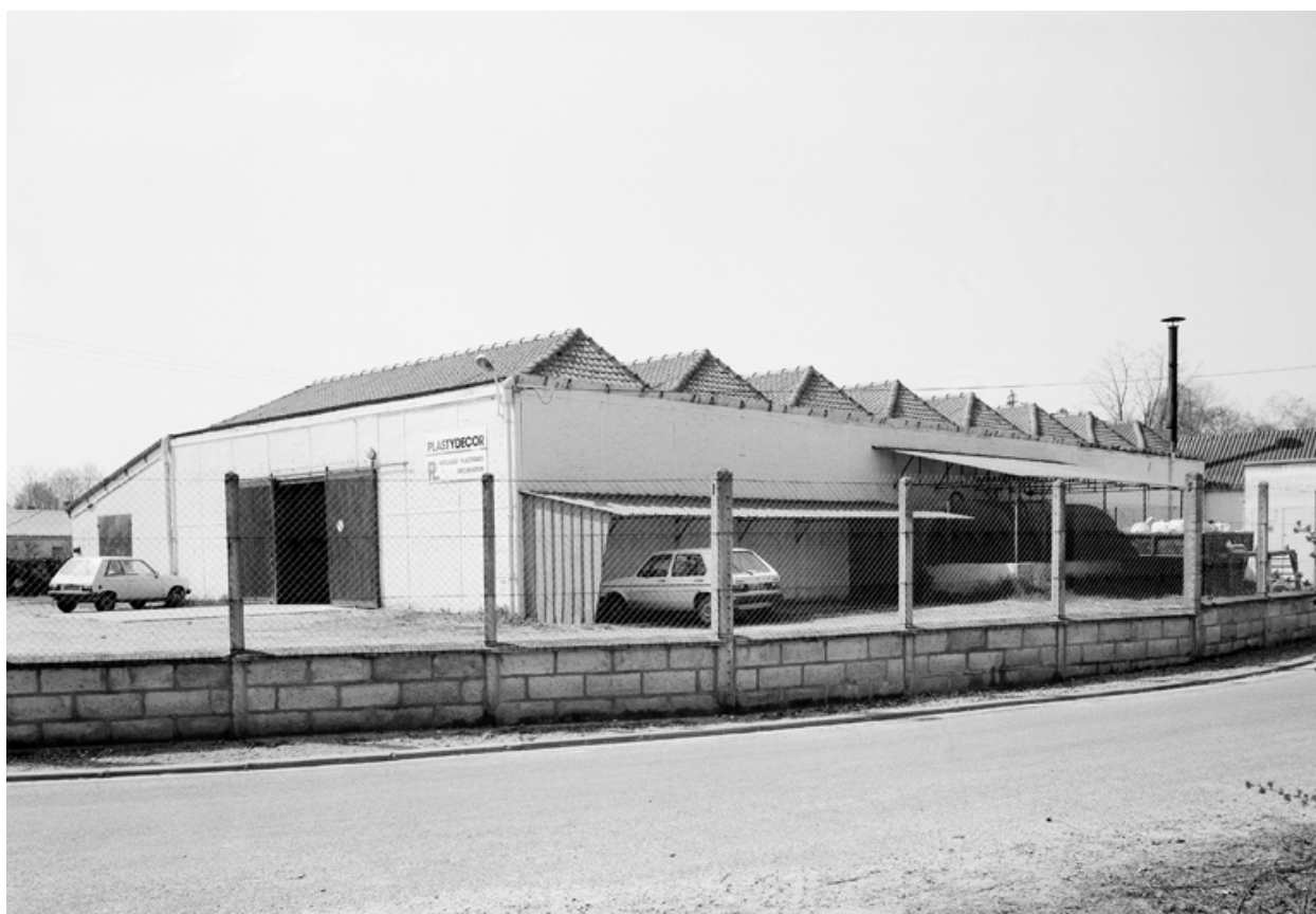
Atelier de fabrication, flanc sud-est, vue partielle.
