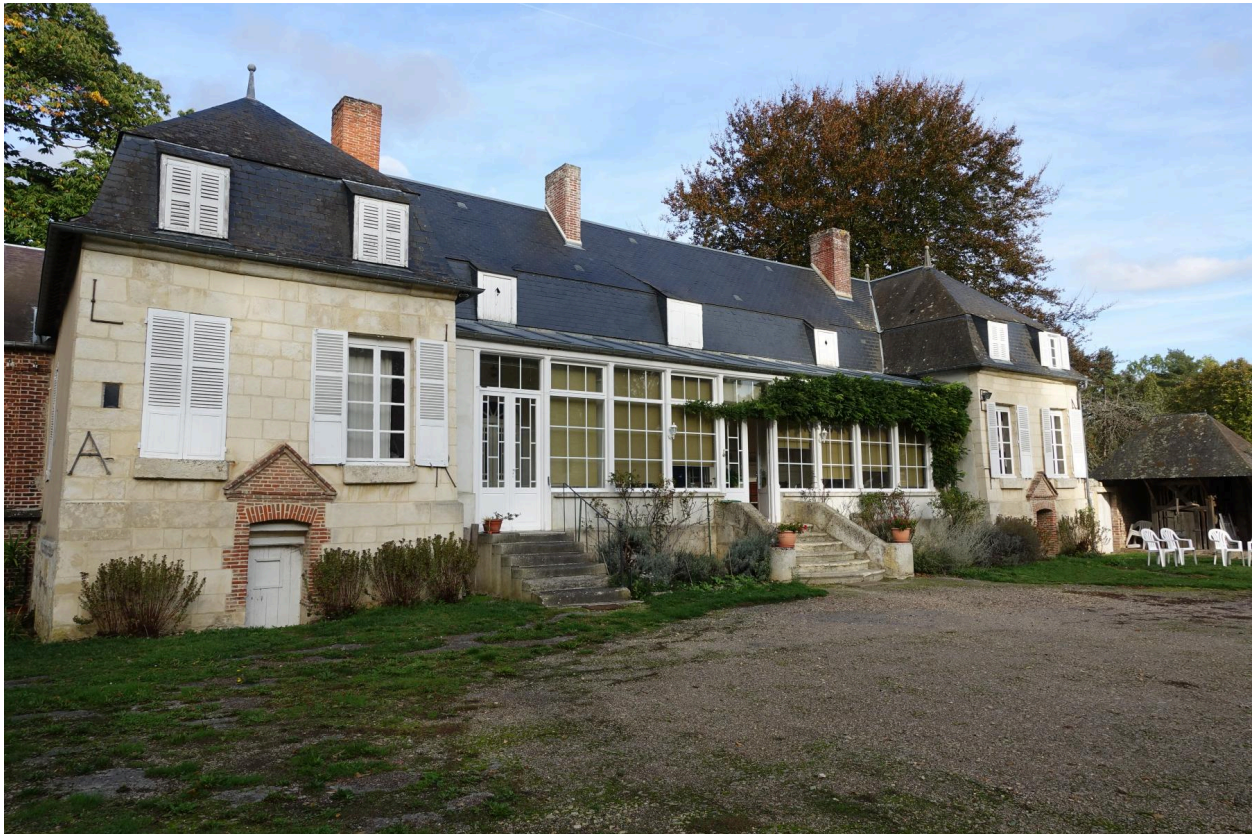
Vue générale du logis depuis la cour.
