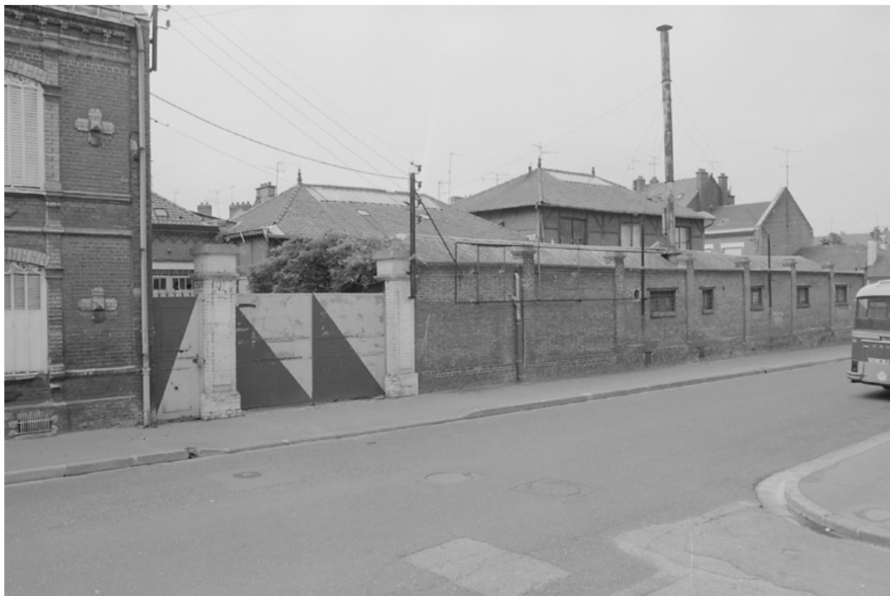
Ateliers de fabrication, flanc est.
