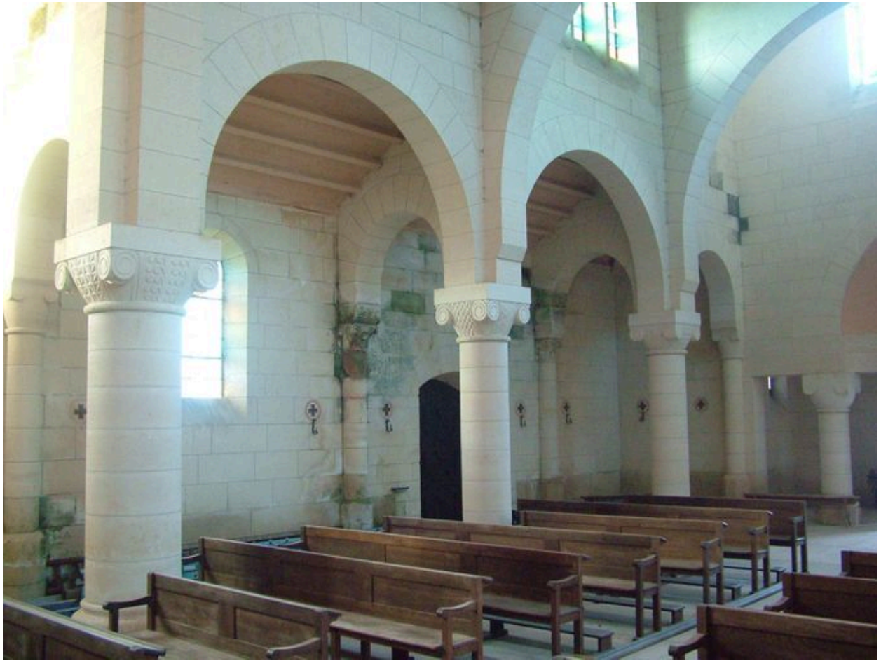
Vue du bas-côté sud.
