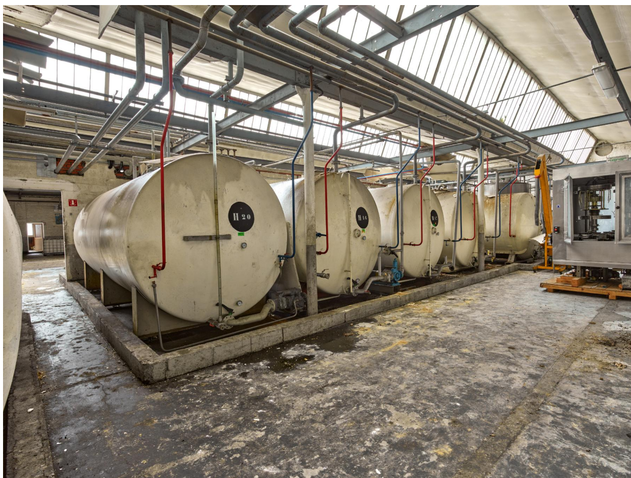
Intérieur de l'ancien laboratoire, vue des cuves de stockage liquide (bâtiment N).
