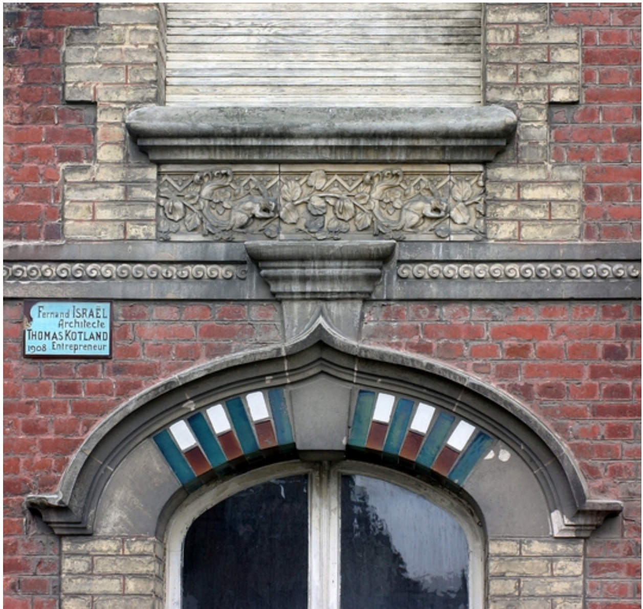
Façade, 6 place du Général Foy : détail.
