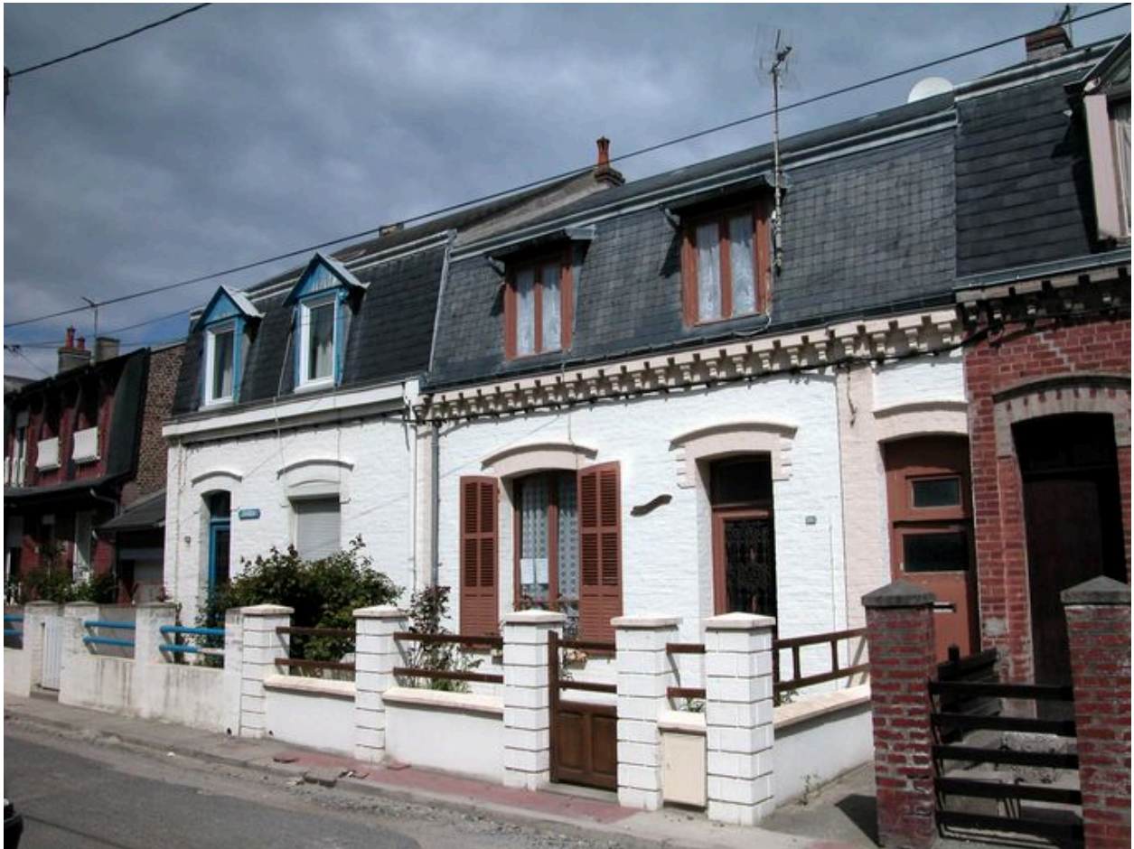
Détail de deux habitations (AZ 72 et 73).
