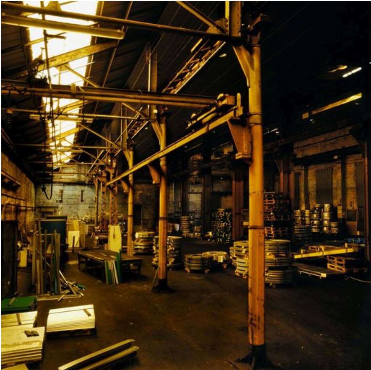
Enfilade des colonnes en fonte.
