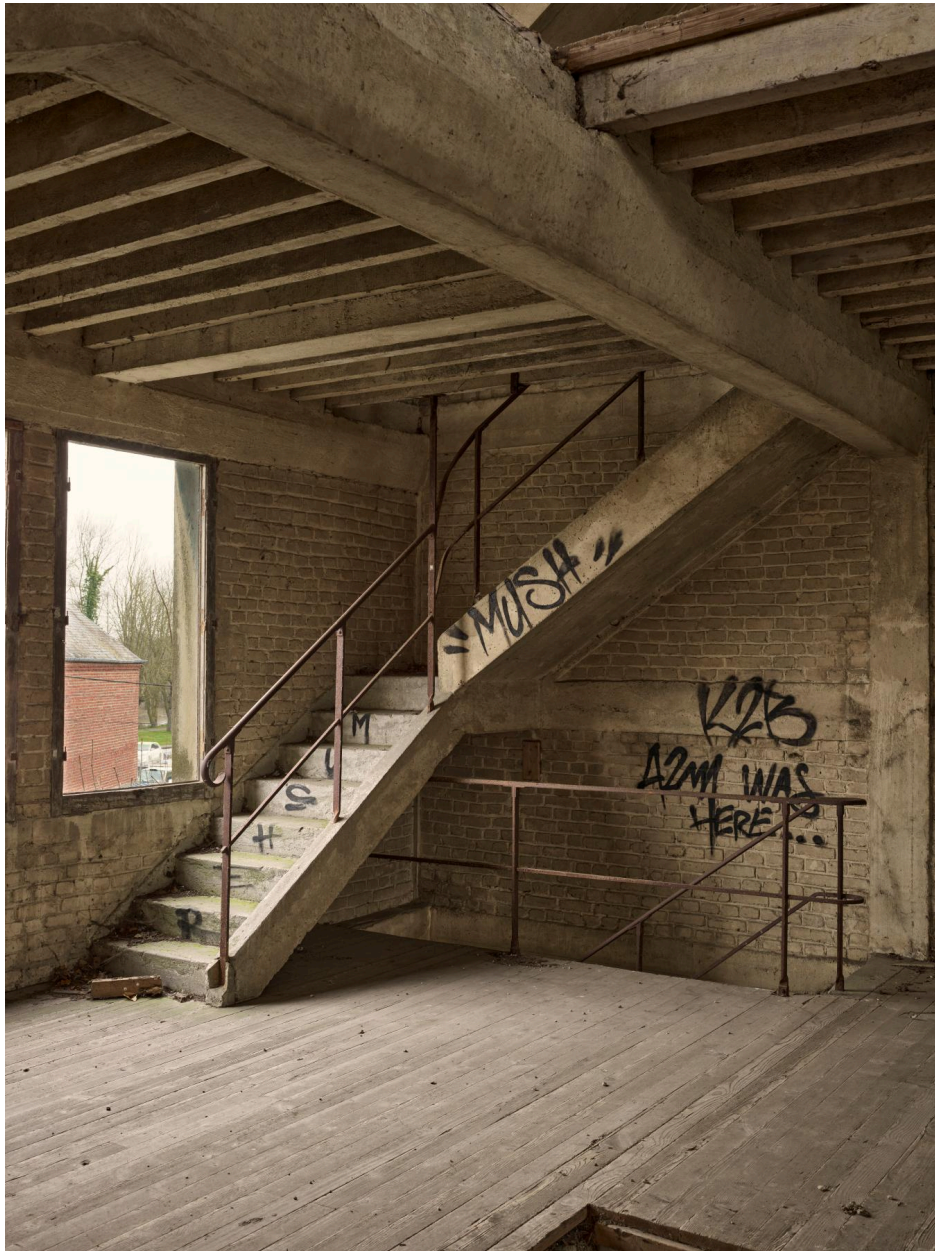
Escalier en béton de la salle des sasseurs.
