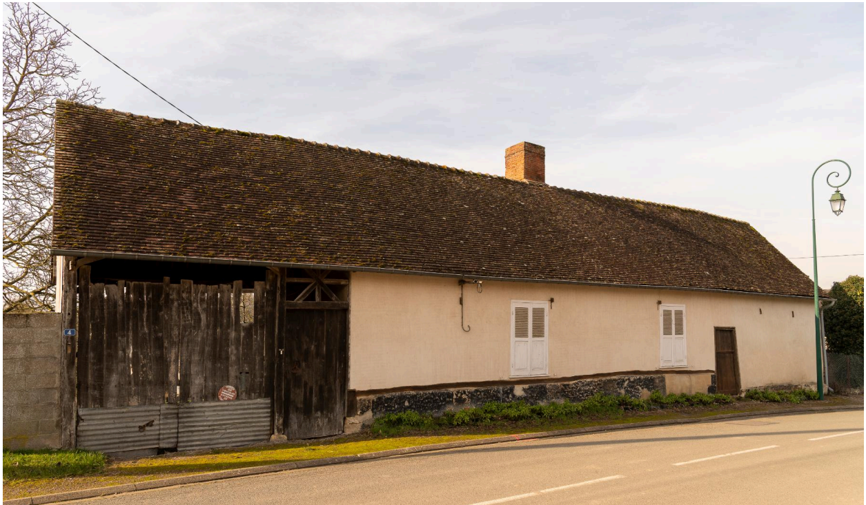
Logis sur rue, n°4 rue Mariette, vue prise depuis le nord-est.
