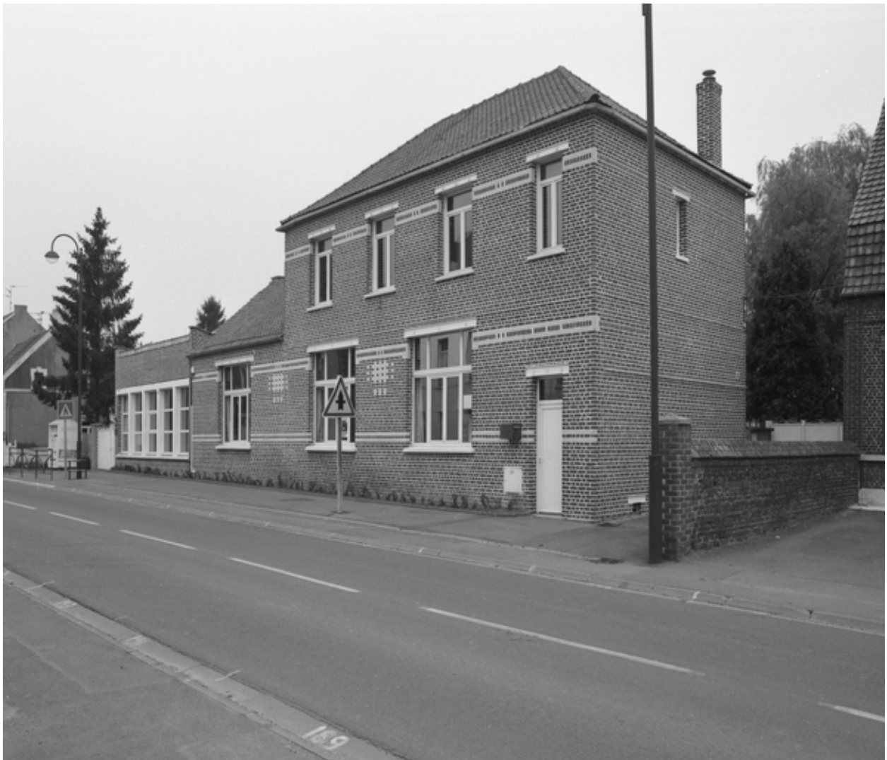
Vue générale de l'école depuis la rue.
