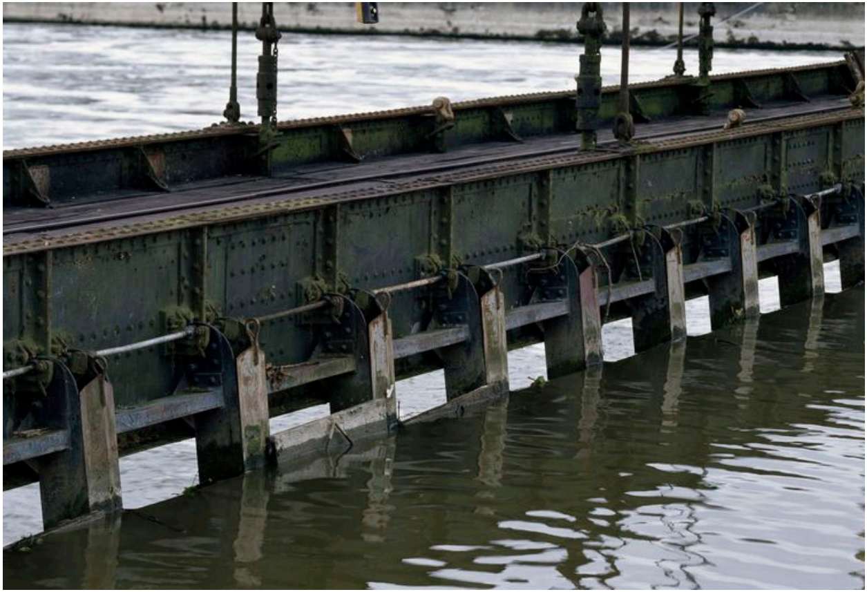
Sarron : détail des fermettes et des vannettes.
