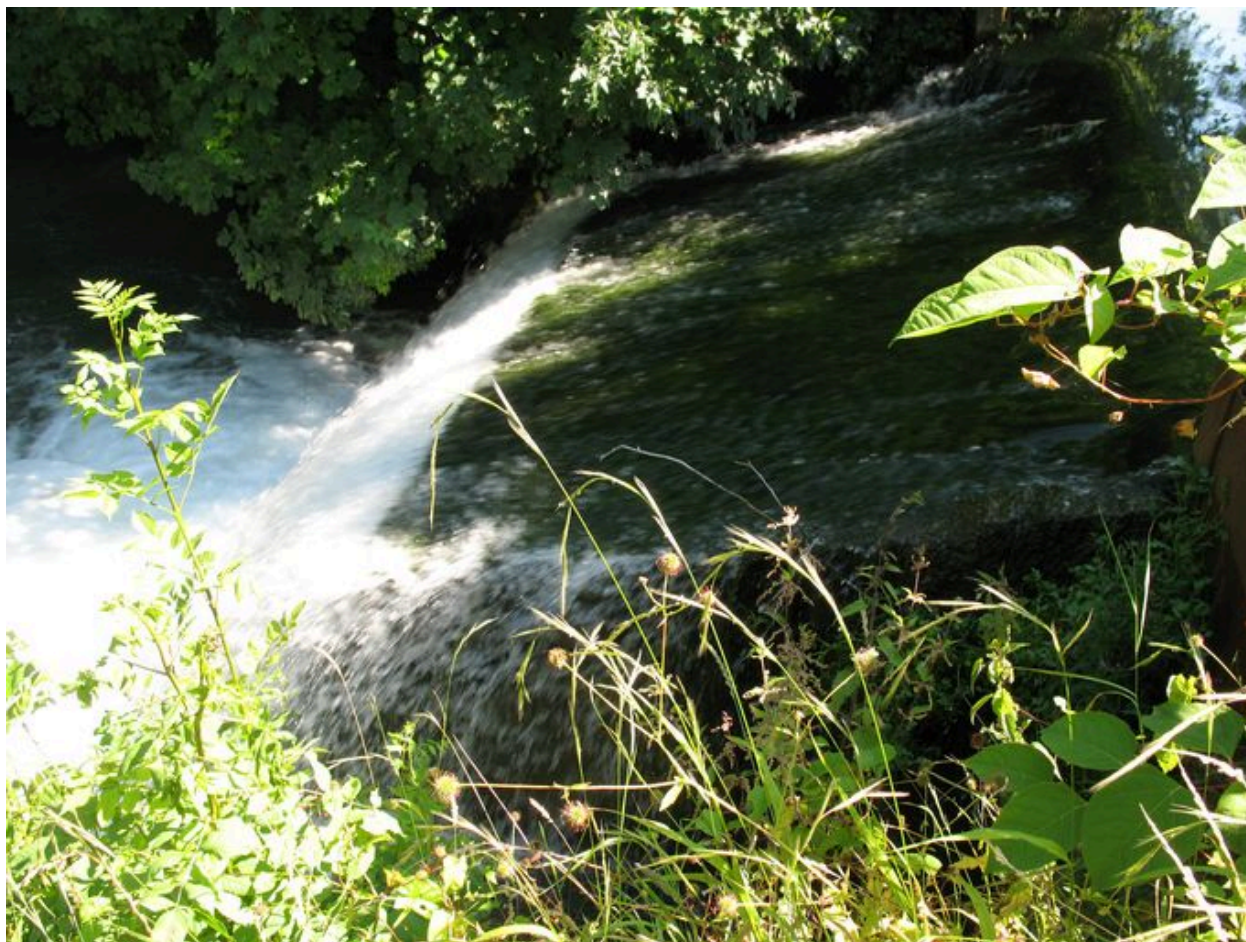
Déversoir du vannage de décharge.
