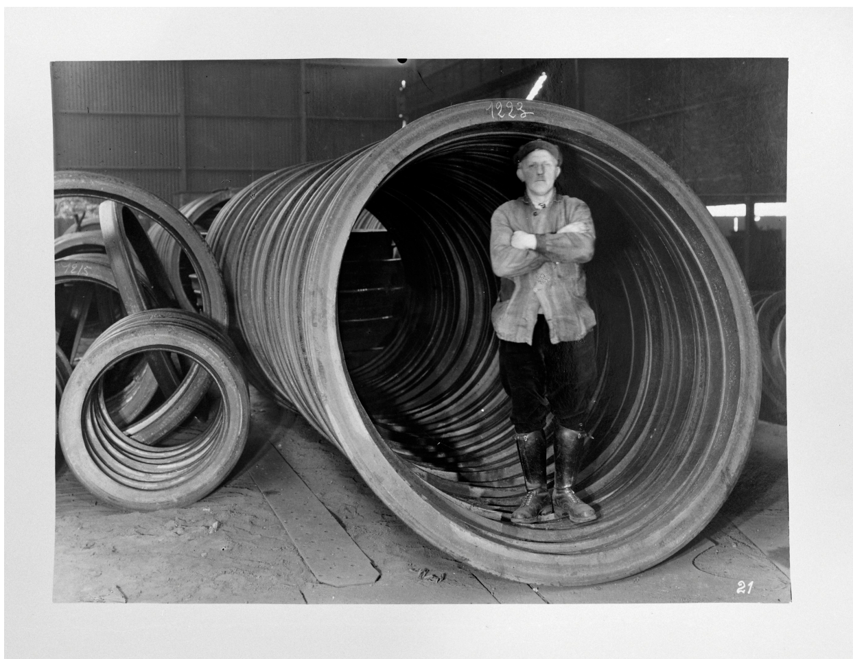
Vue générale des bandages. Photographie ancienne, auteur inconnu, sans date (coll. part.).
