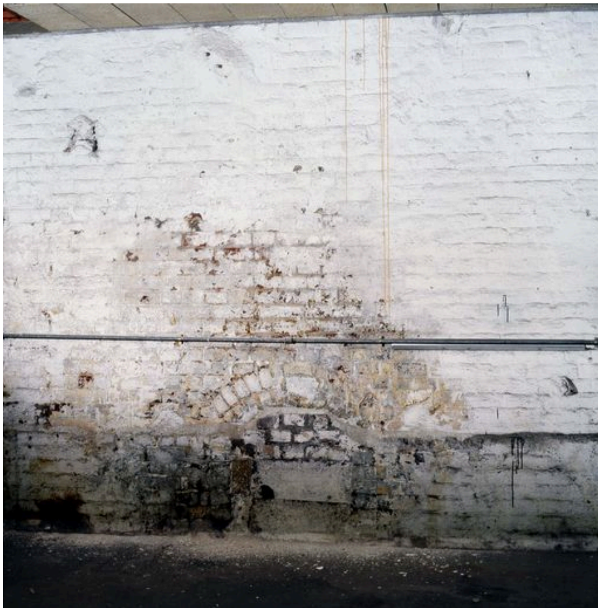
Intérieur du foyer de la cheminée.
