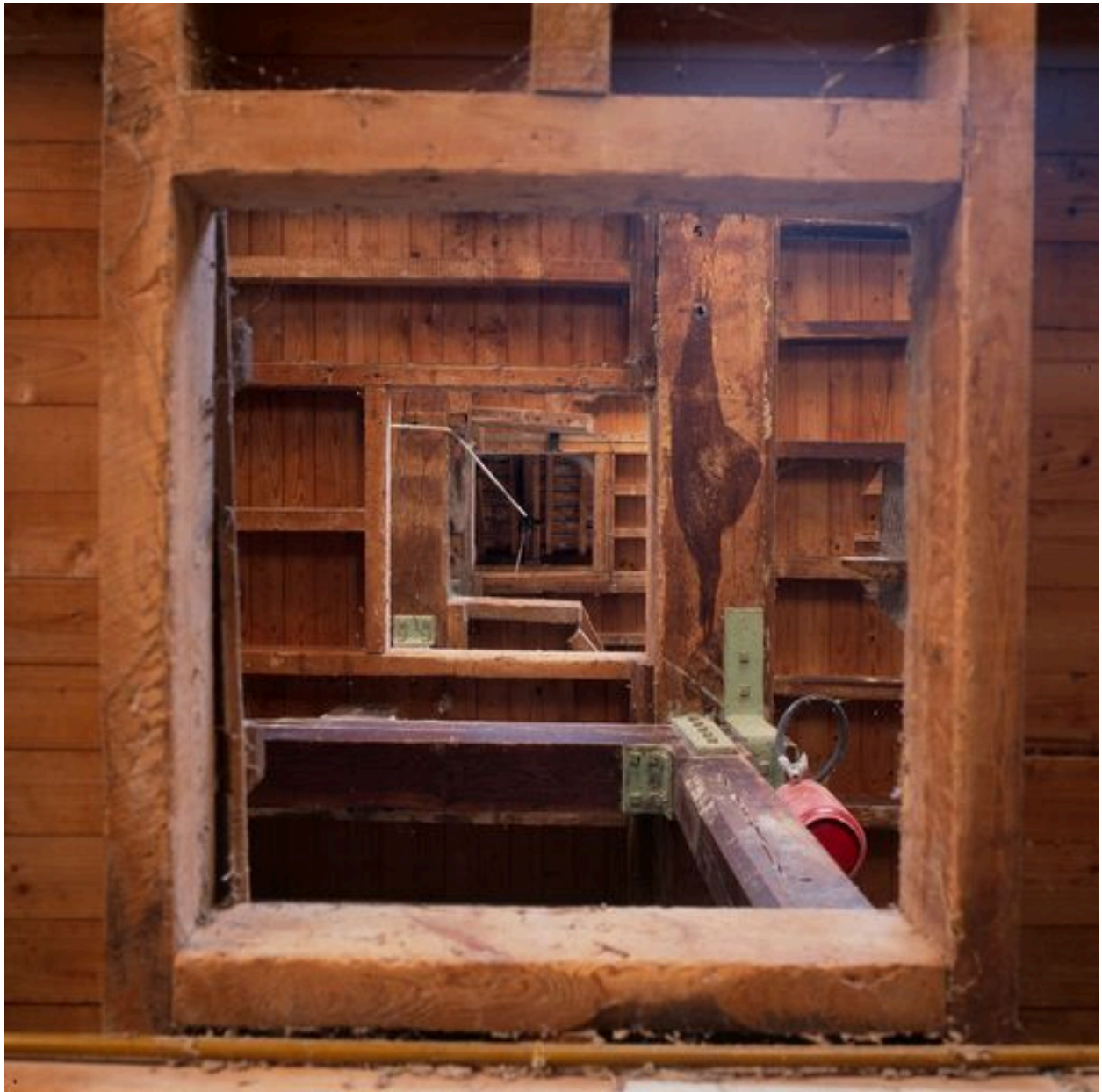
Elévation intérieure de la minoterie depuis la trappe monte-sac.
